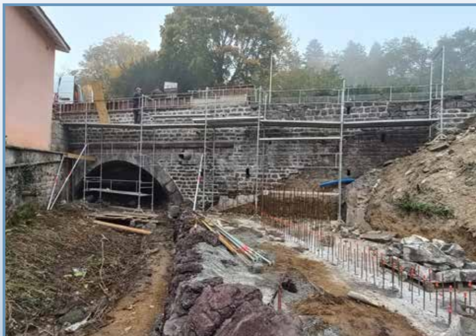
Pendant les travaux
