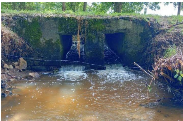
La Bouble (avant travaux)
