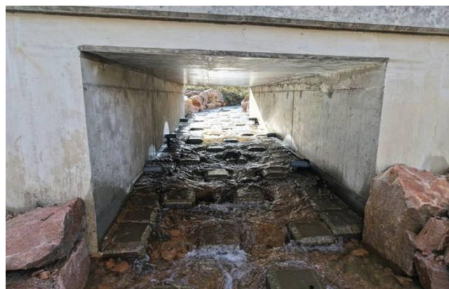
La Bouble (après travaux)
