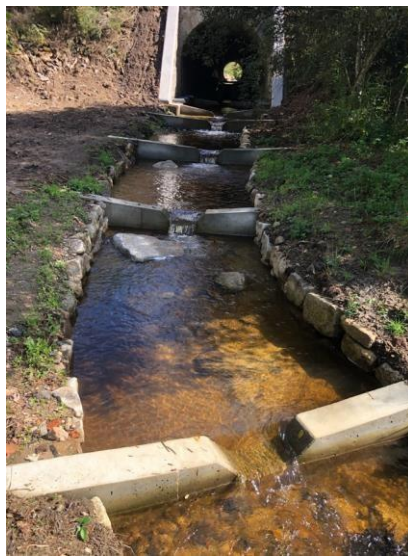
Pont de la mort (après travaux)
