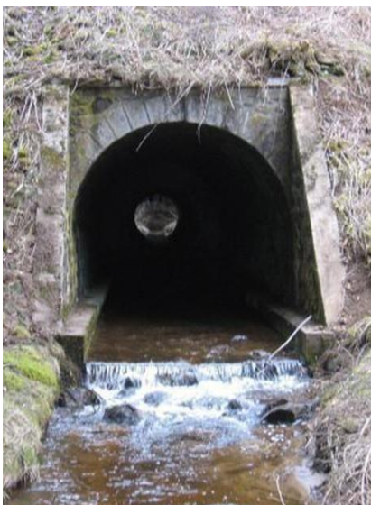
Pont de la mort (avant travaux)
