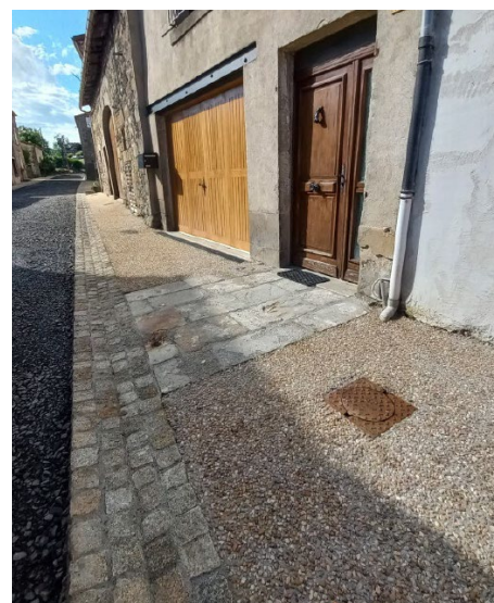
Le chantier de la traverse de Mauzun
